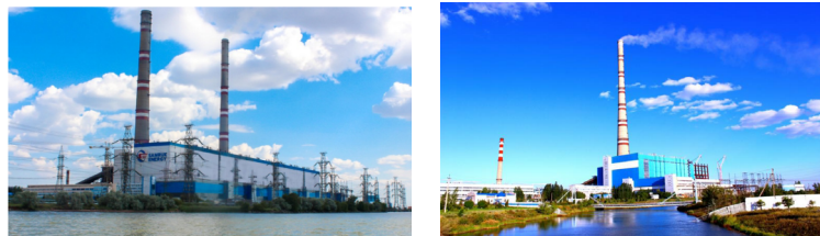
2 – сурет. Екібастұз ГРЭС-2 Екібастұз қаласындағы электр станциясы.
